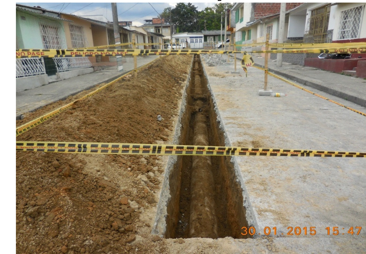
Foto: Sub Gerencia Técnica
