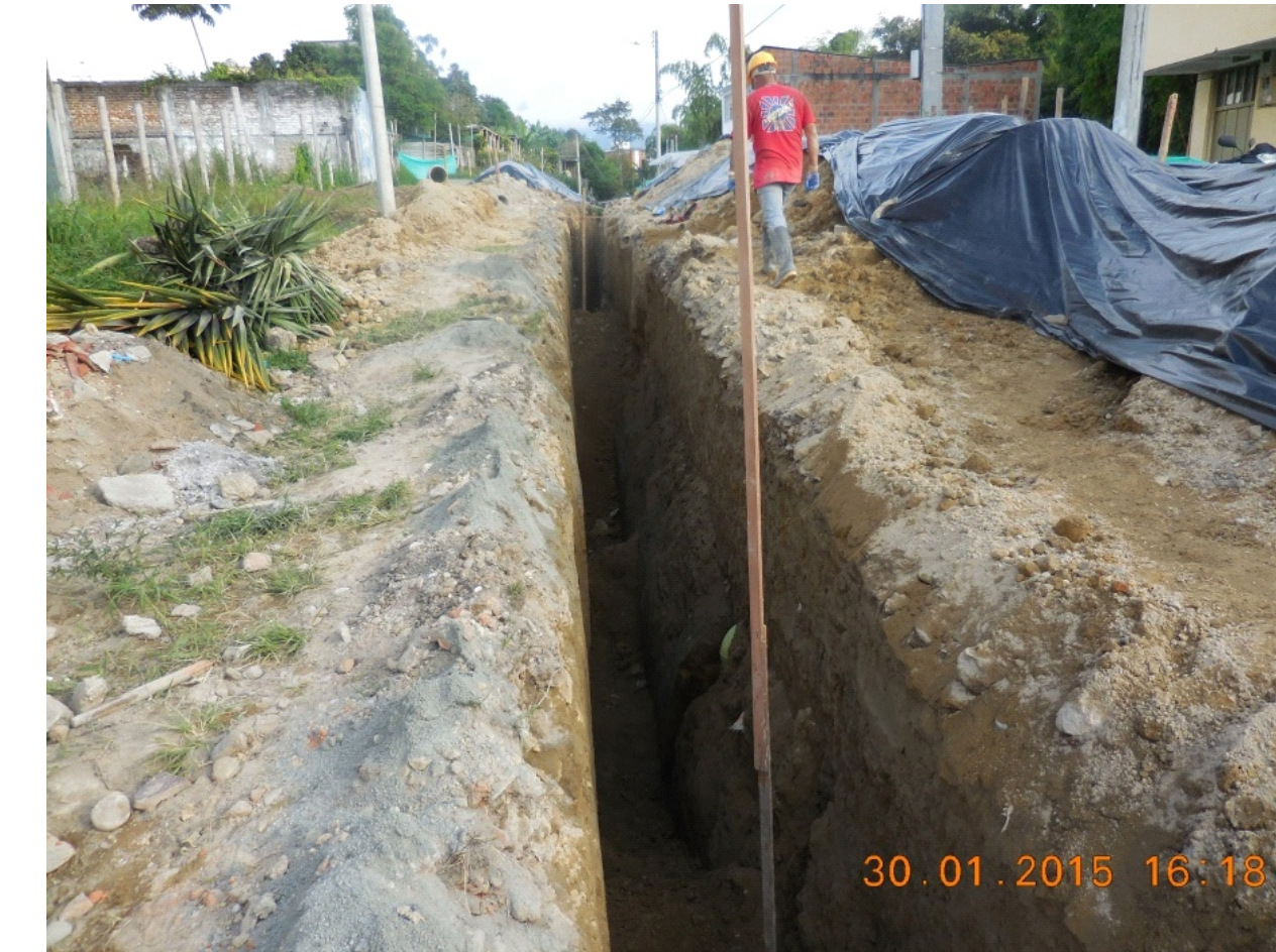
Foto: Sub Gerencia Técnica
