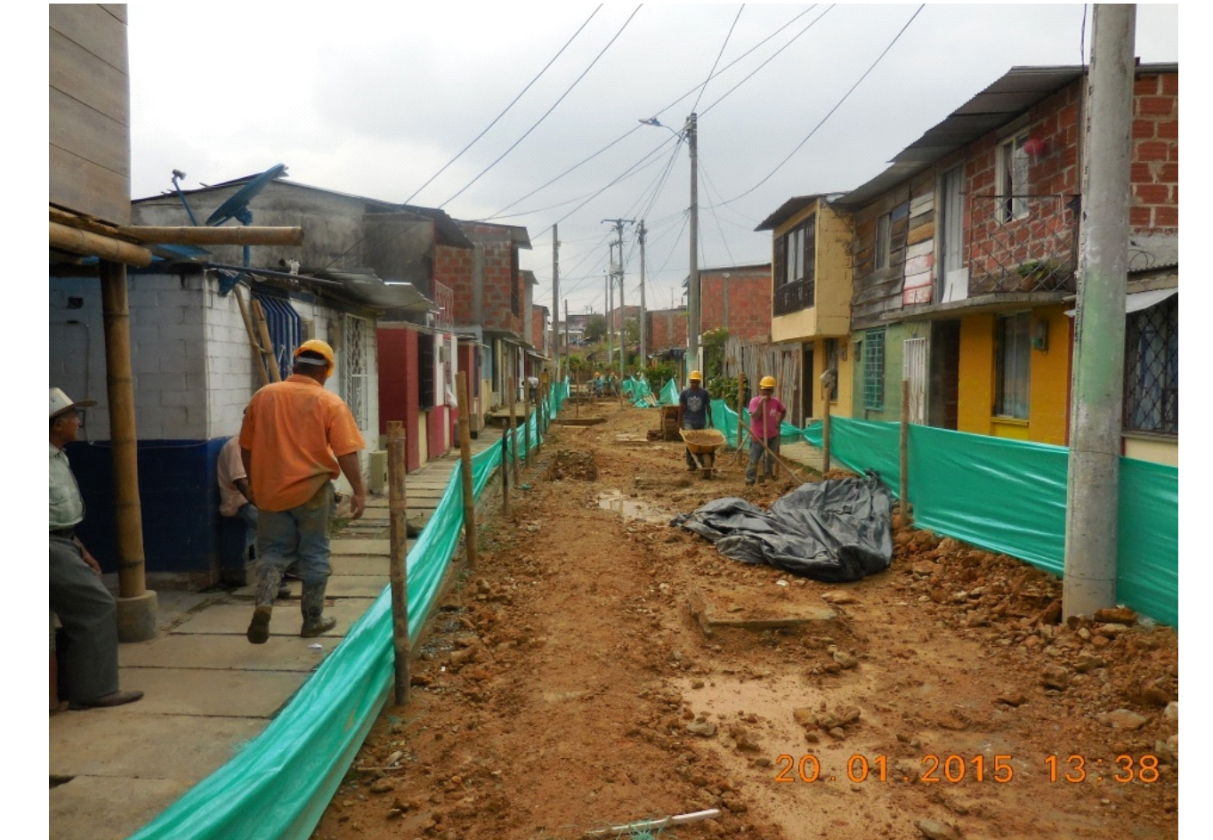
Foto: Sub Gerencia Técnica
